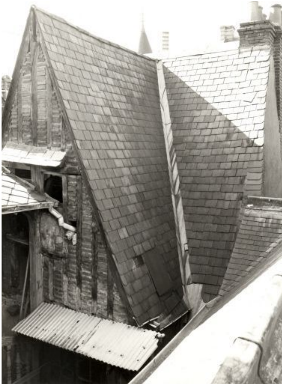
Vue d'ensemble de la partie arrière de la couverture du corps antérieur, depuis la maison du 5, rue de l'Oisellerie.
