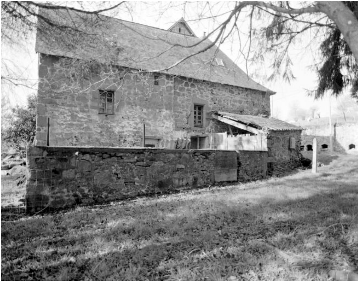
Les dépendances du moulin détruit au 19e siècle. Façade nord-est du corps de bâtiment bas formant retour vers le sud-est.
