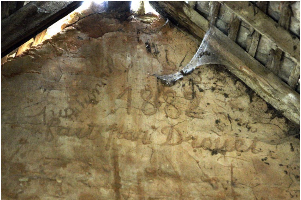
Grange-étables-remise, pignon gauche, face interne : inscriptions et date portée.
