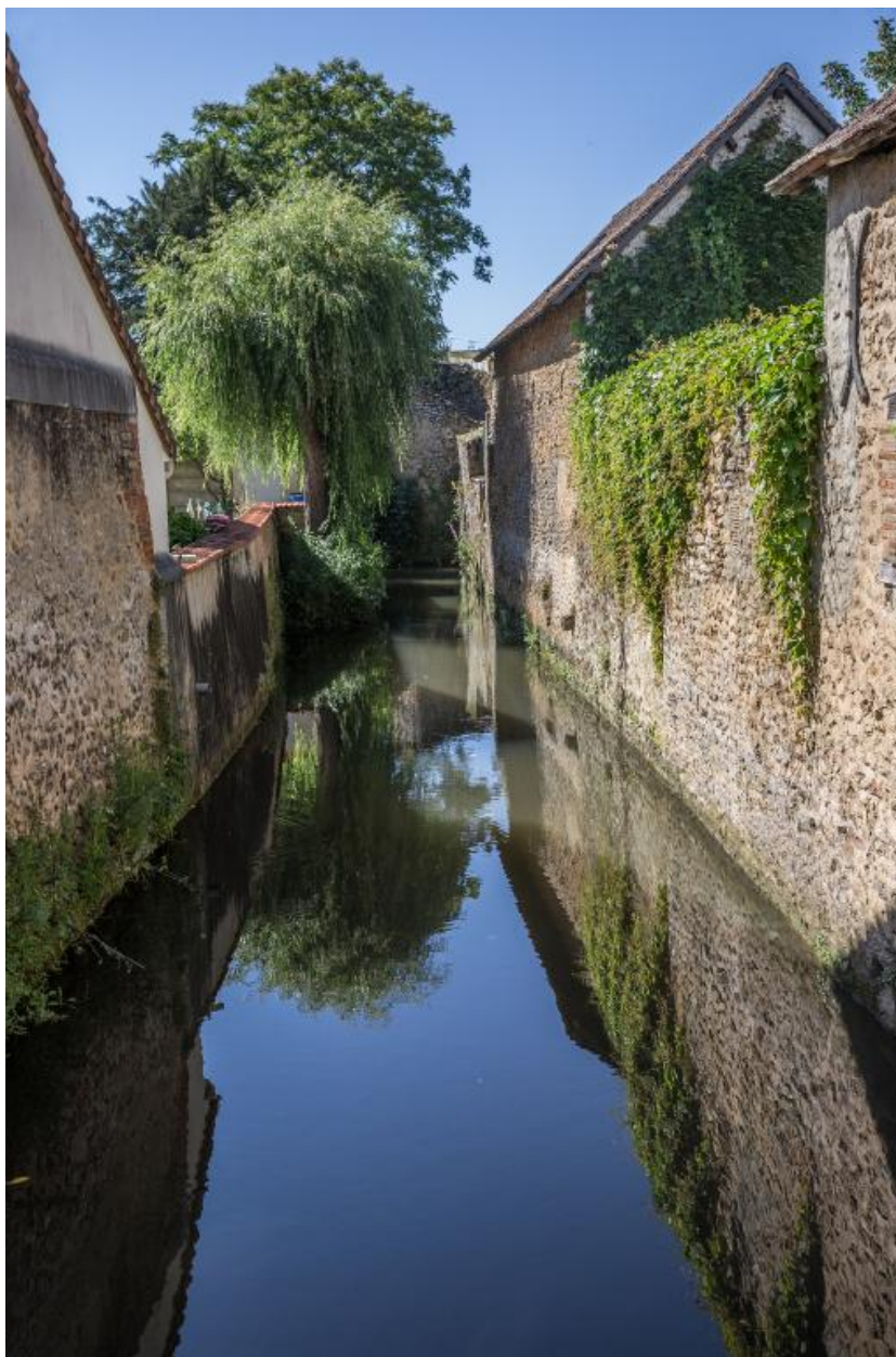
Le Dué et une portion de rempart, rue des Vieux-Ponts.
