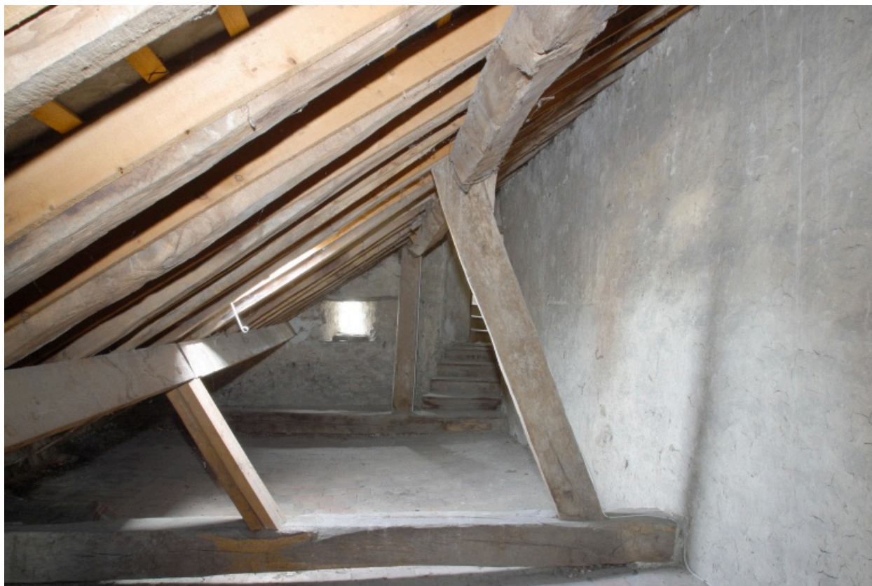
Comble de l'appentis : la charpente depuis l'ouest.
