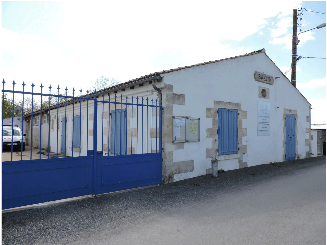
La maison éclusière vue depuis le nord-est.
