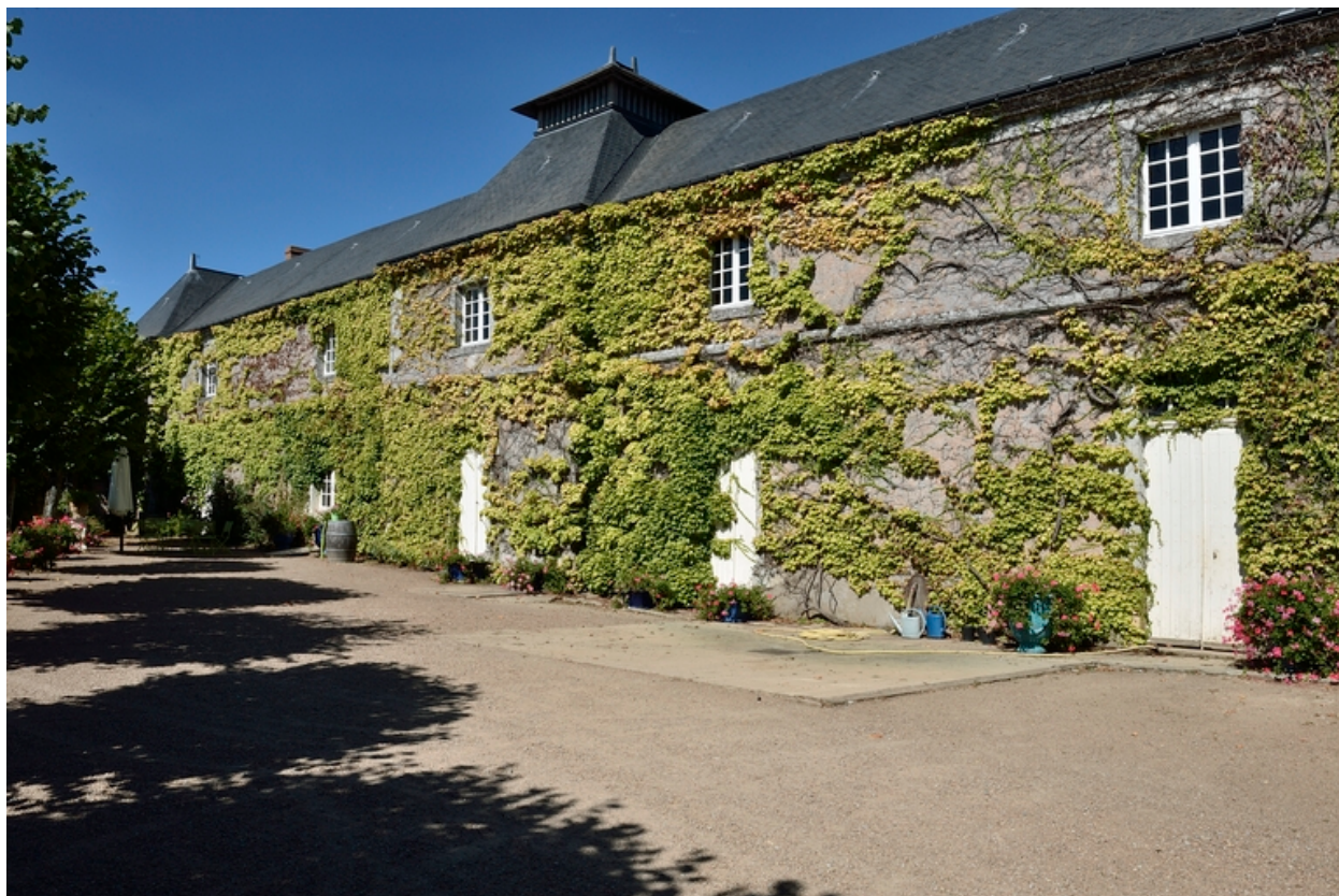
Chai. Vue de la façade sud.
