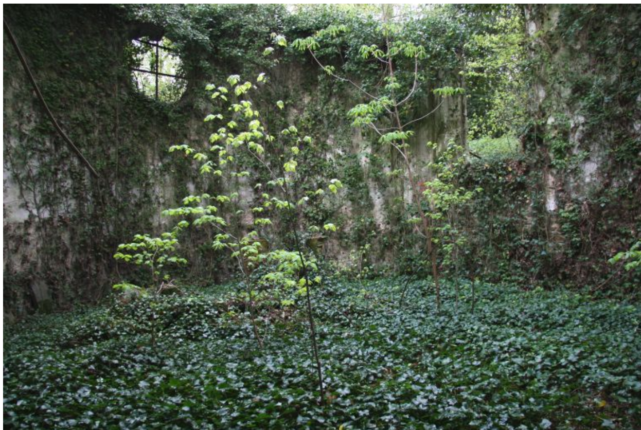
La chapelle, intérieur : le mur sur la terrasse.
