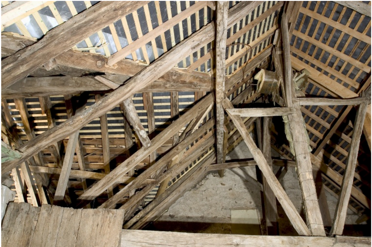
Intérieur du logis, comble : la charpente du corps principal et la jonction avec le pavillon vues depuis le sud-ouest.
