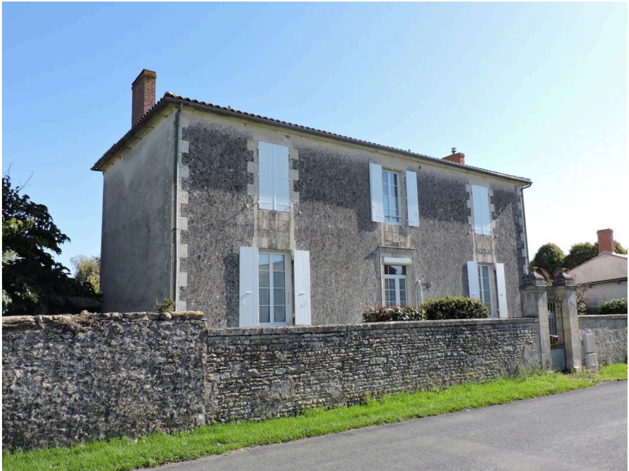
Maison de maître datée de 1864, rue de la Voie et rue de la Cigogne.
