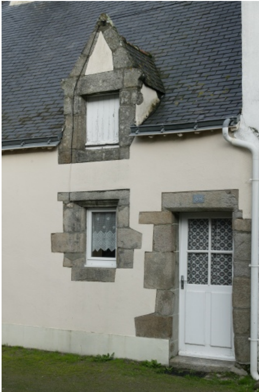
Vue de la façade sur rue recadrée sur le n° 68.
