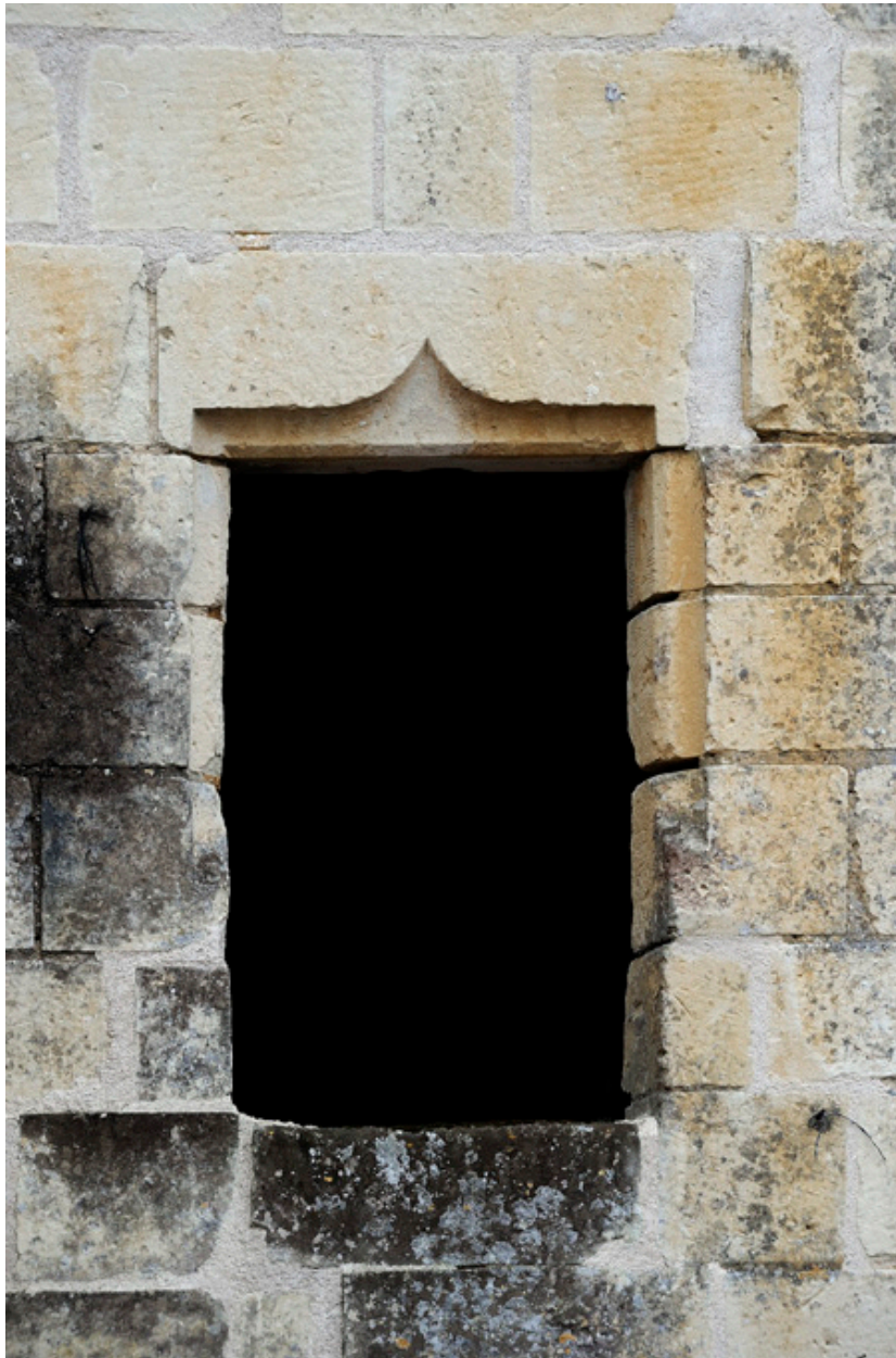
Tourelle d'escalier, baie de l'étage : encadrement à cavet avec congés, linteau à accolade.
