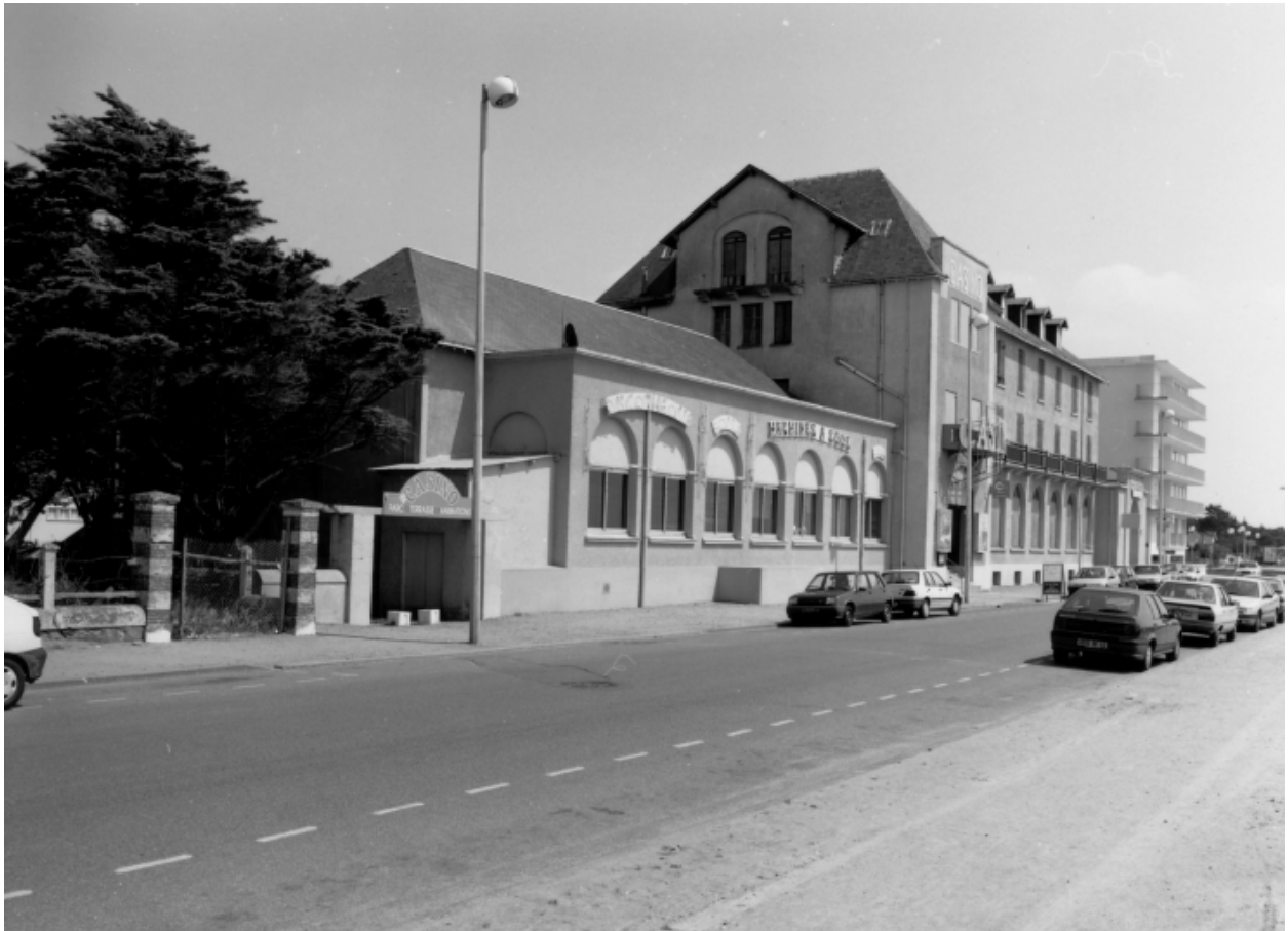
Elévation antérieure vue du nord-ouest.
