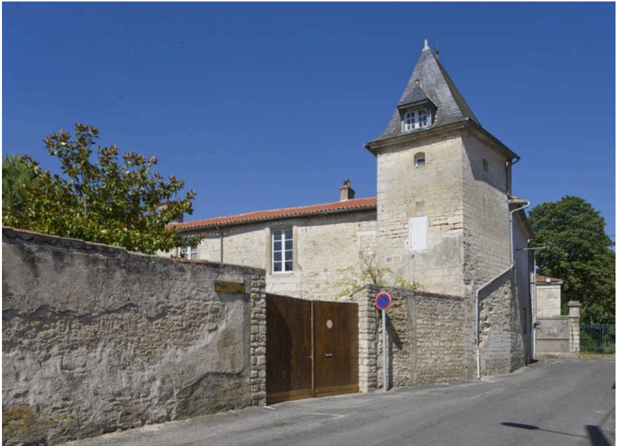
Vue prise de l'est de la rue du Pont-Gentilz, montrant la partie ancienne.
