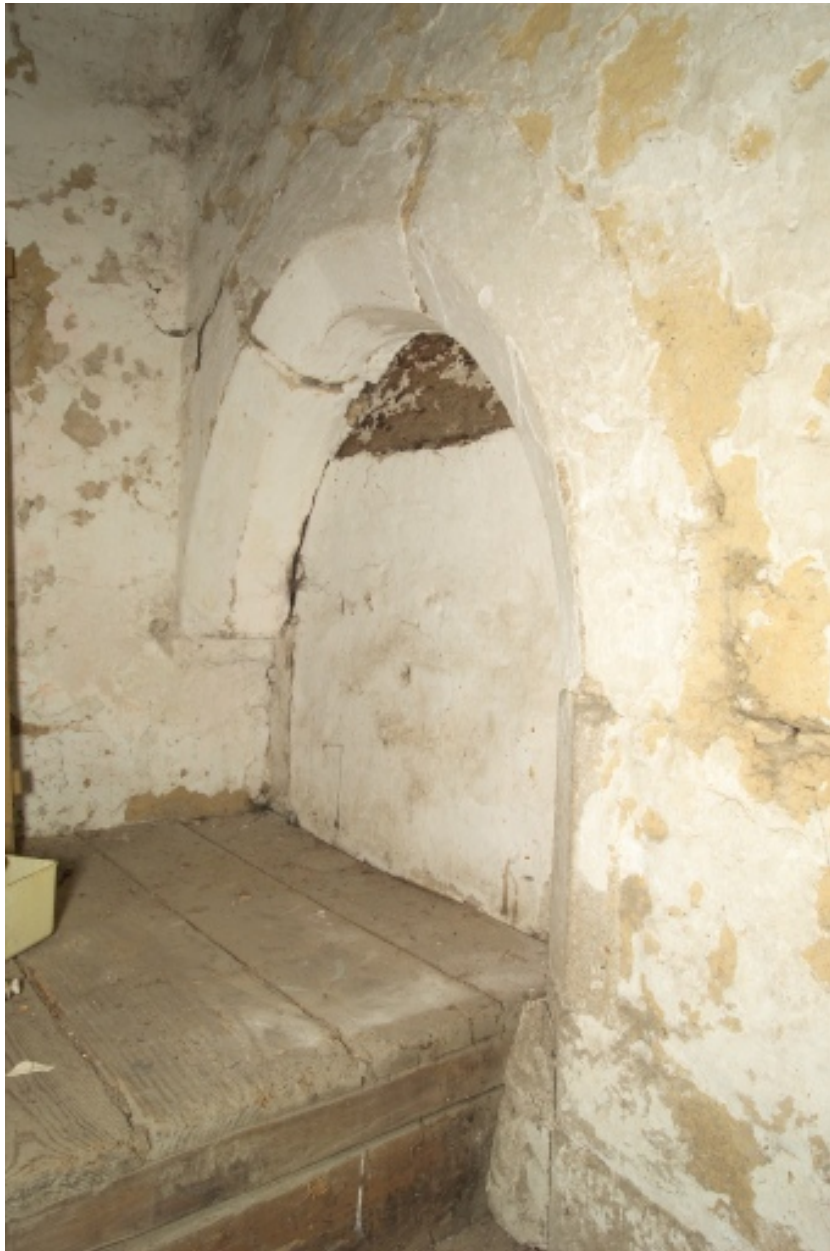
Porte murée dans la cage d'escalier.
