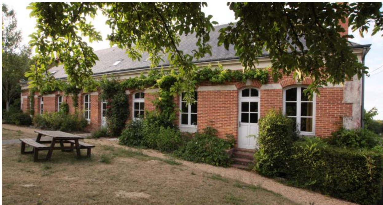
Façade antérieure sur cour.
