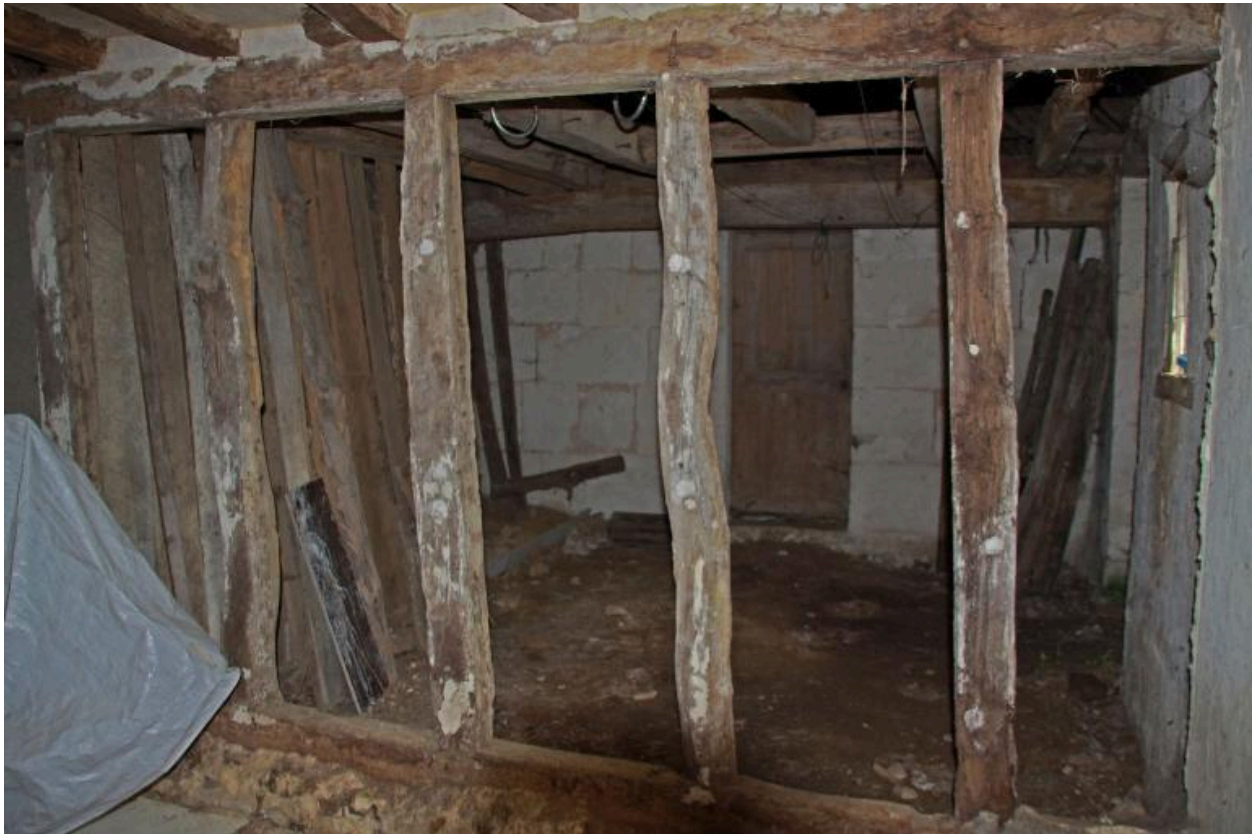
Vestiges d'une cloison à pan de bois centrale.
