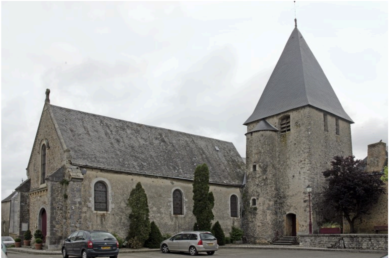
Les élévations ouest et sud vues depuis la place Jacques-Favrot.
