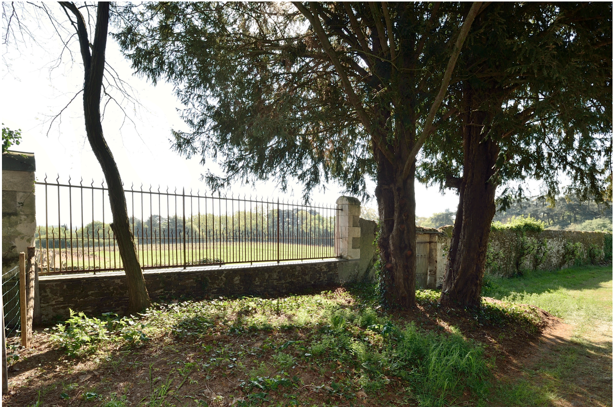
Vue de l'ahah dans le mur de clôture.
