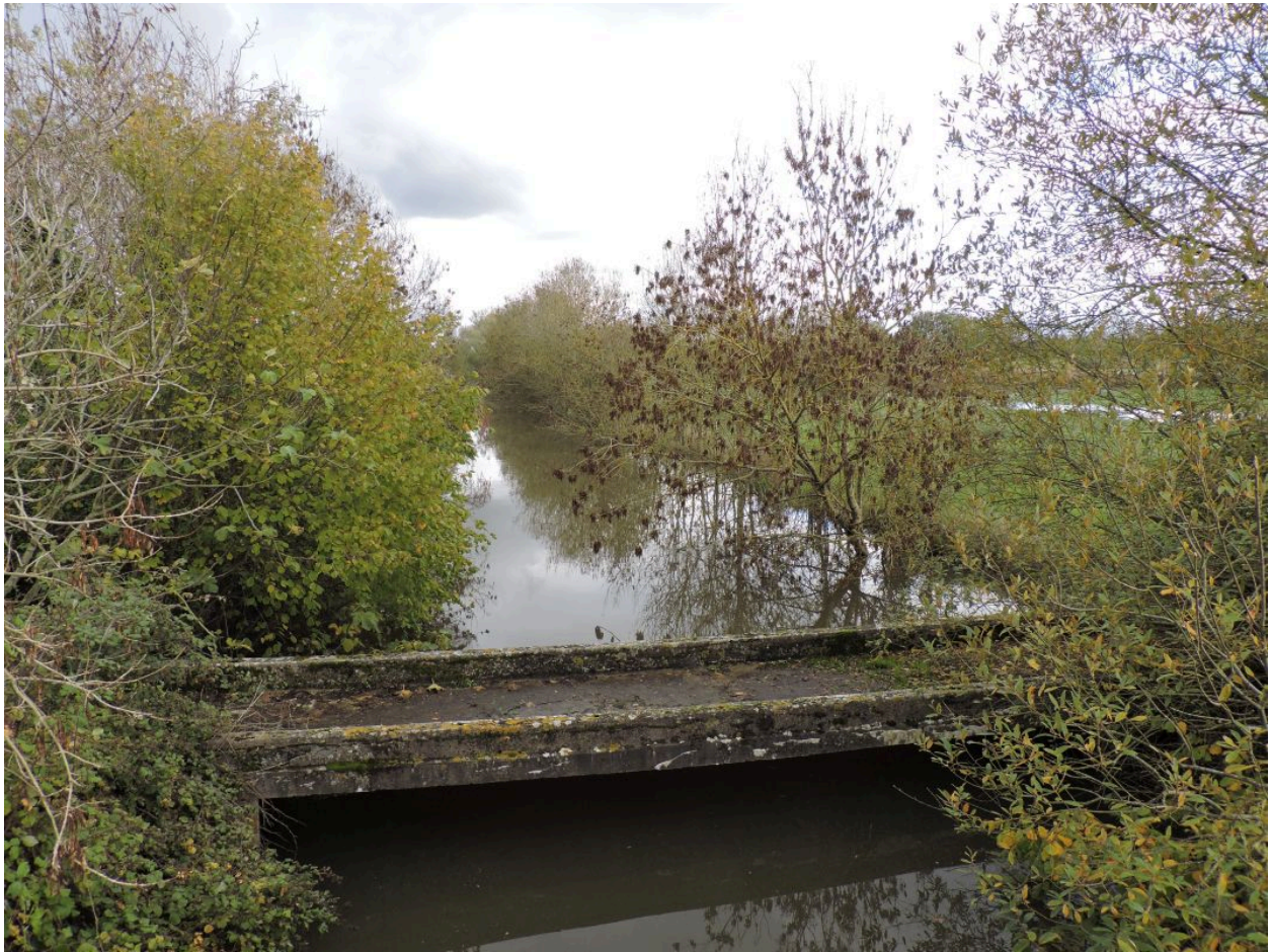
Ancienne passerelle en amont des pons, sur le Contrebot de Vix.
