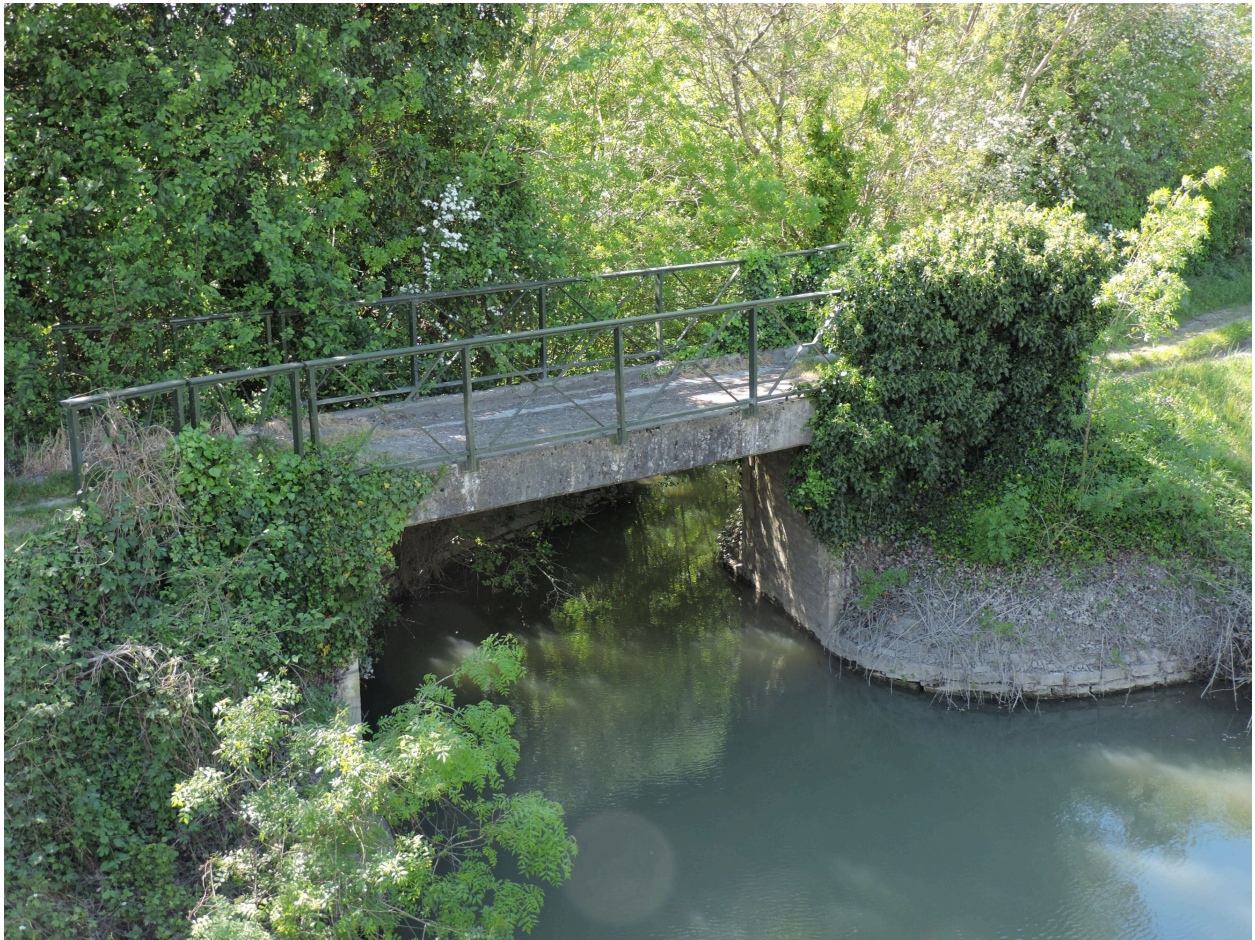
Passerelle de halage au pied du pont de la Pichonnière, sur la rive gauche du canal de Bourneau.
