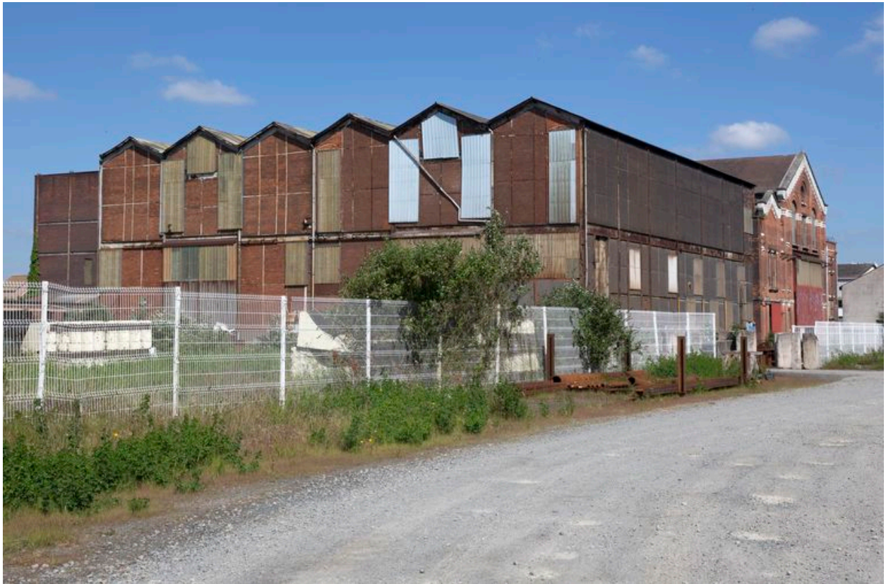
Chaufferie et halle centrale.
