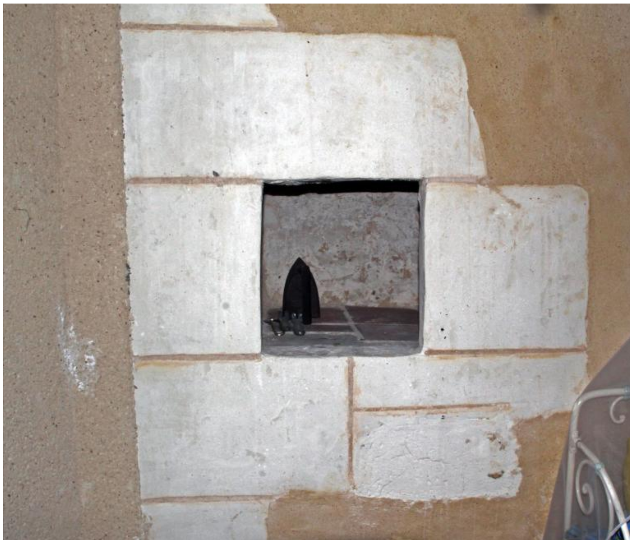
Maison, rez-de-chaussée : niche.
