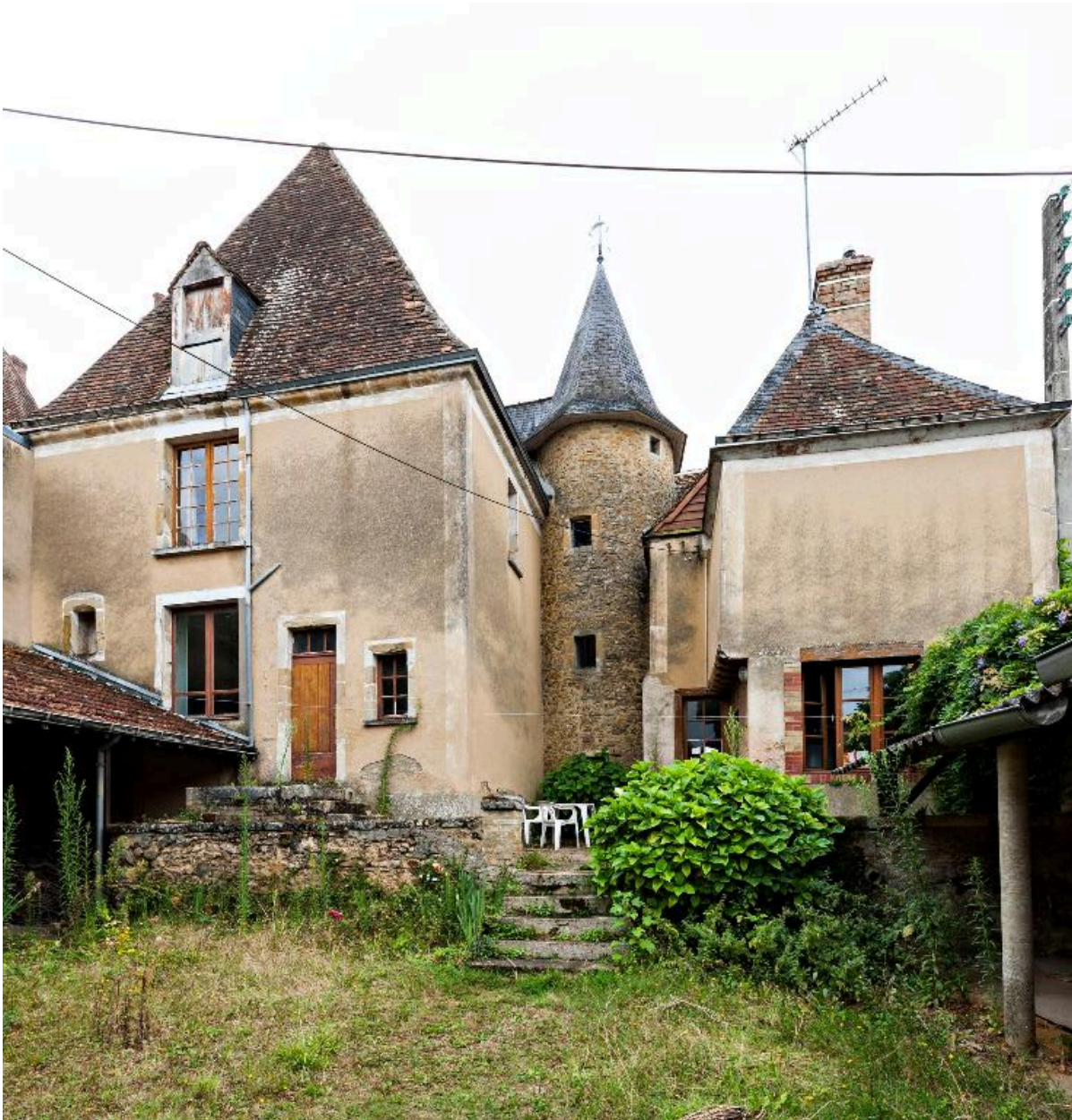
Elévations postérieure de la maison n° 14.
