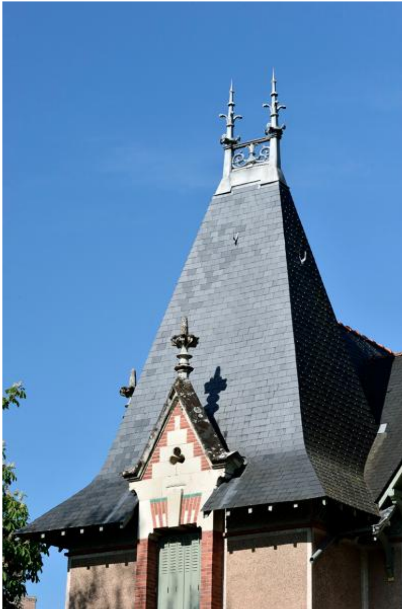
Épiré. Castel Fleuri. Détail du toit en pavillon.
