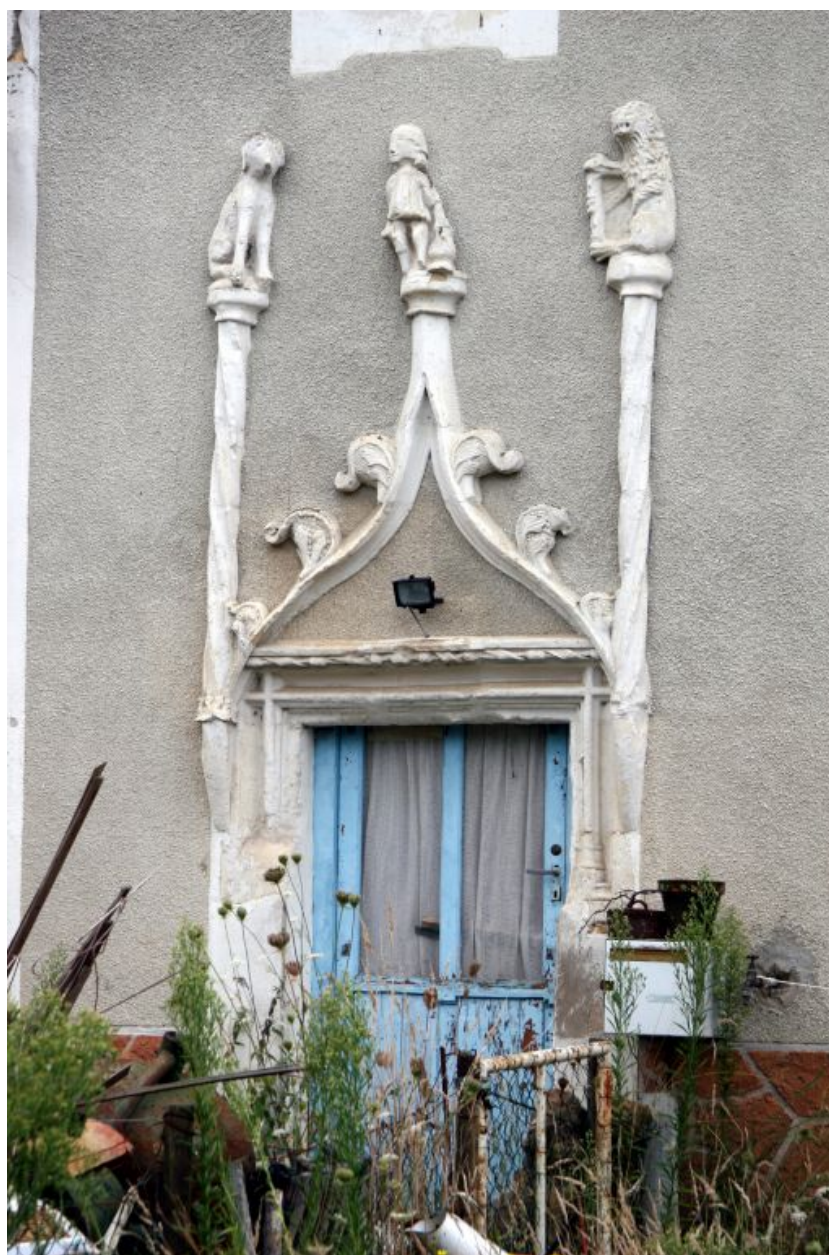
Le logis : porte d'entrée.
