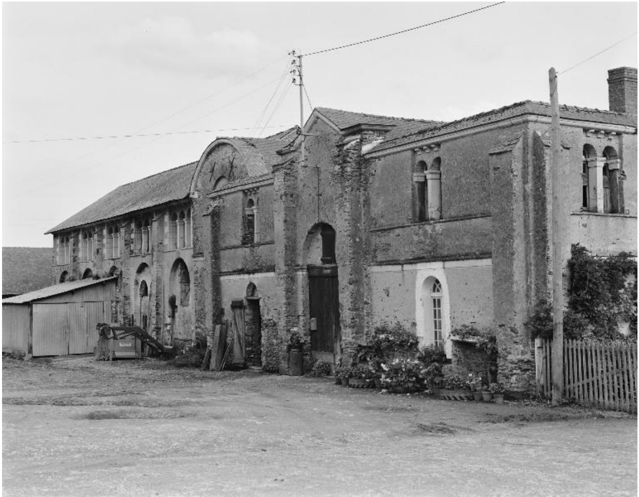
Bâtiment est, façade nord (1984).
