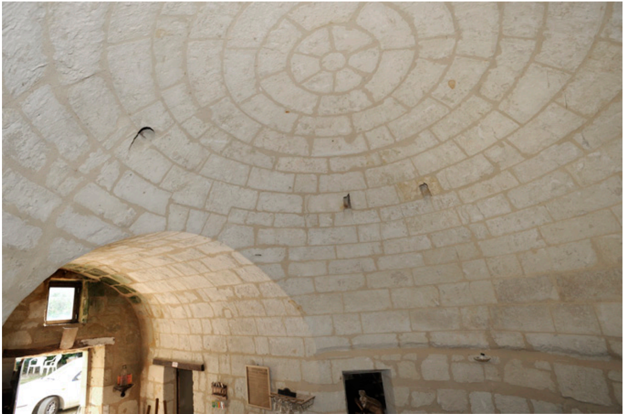
Moulin Picard (intérieur) : voûtes de la cave et du massereau (2).
