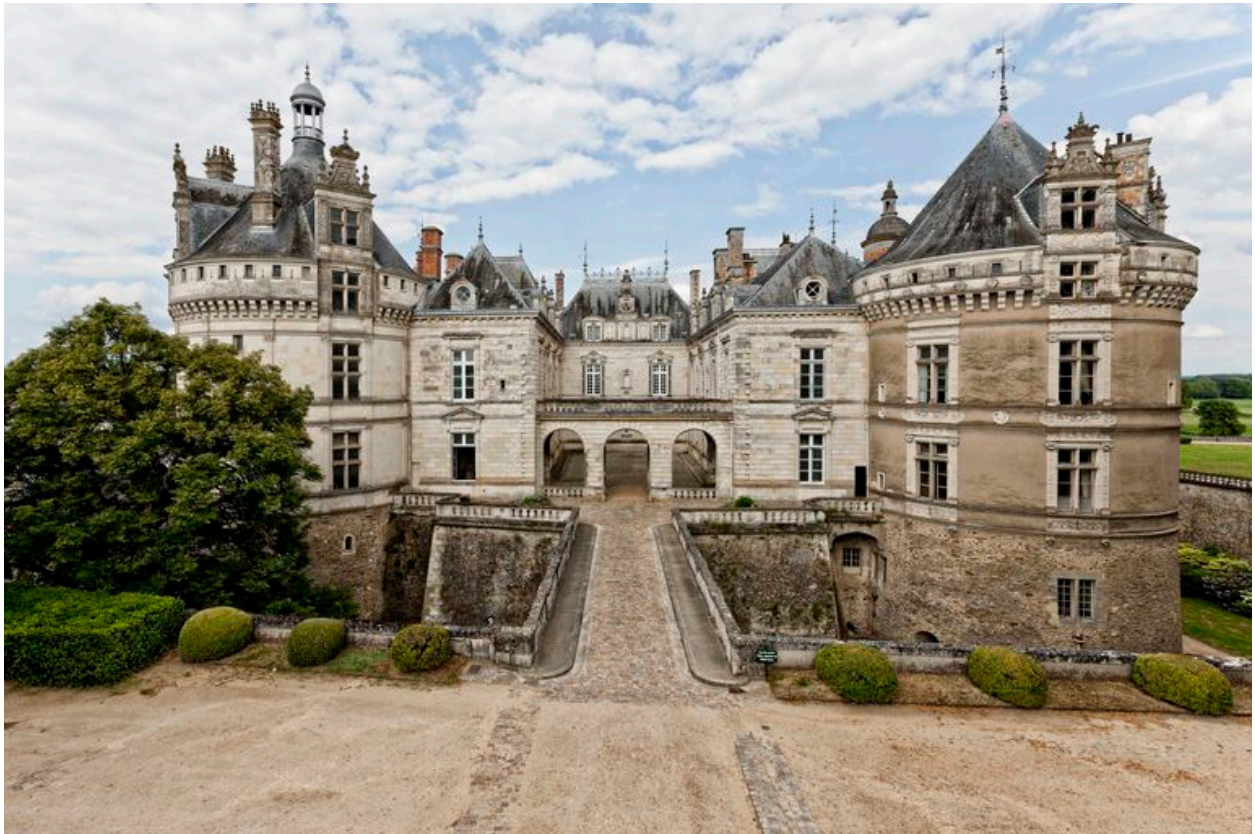
Vue d'ensemble de la façade occidentale.
