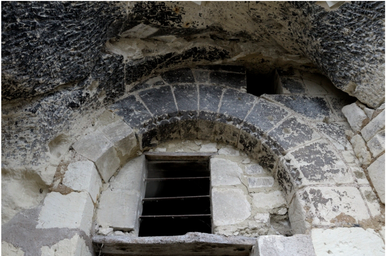
Détail du décor de demi-besants affrontés du chanfrein de l'arc plein-cintre de couverture de la porte (2e moitié 12e siècle).
