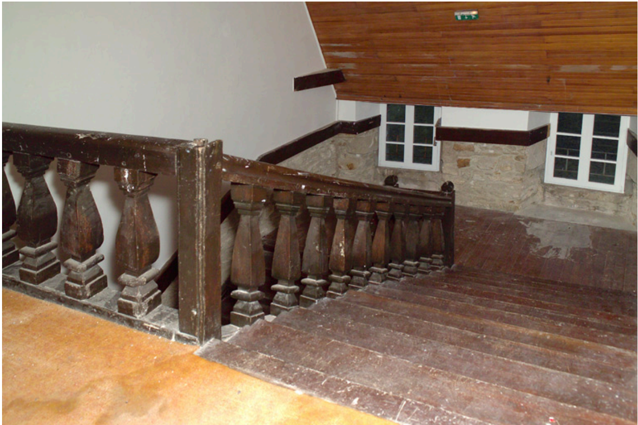
Escalier en bois du bâtiment est.
