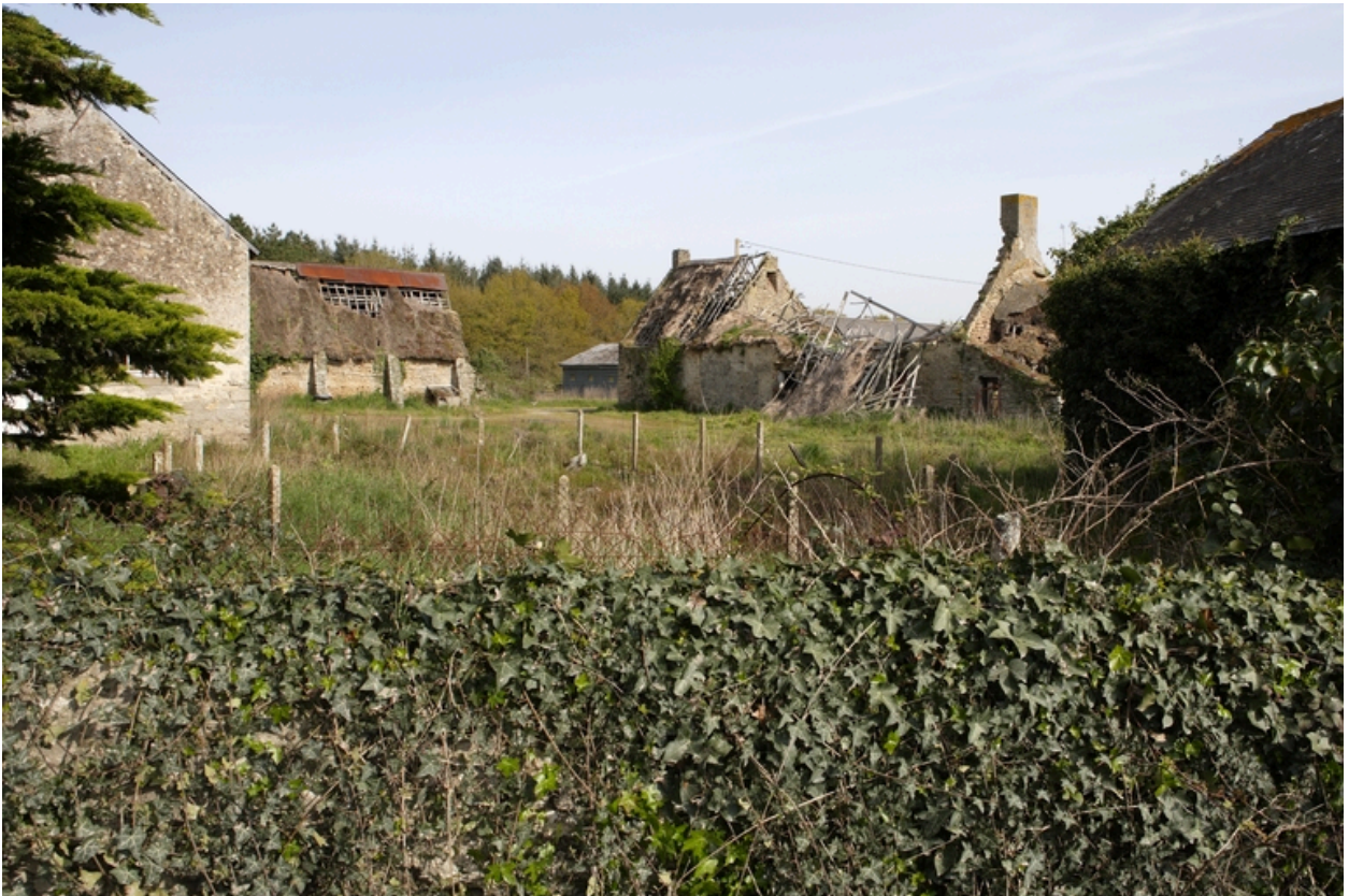
Vue d'ensemble depuis la route à l'est.
