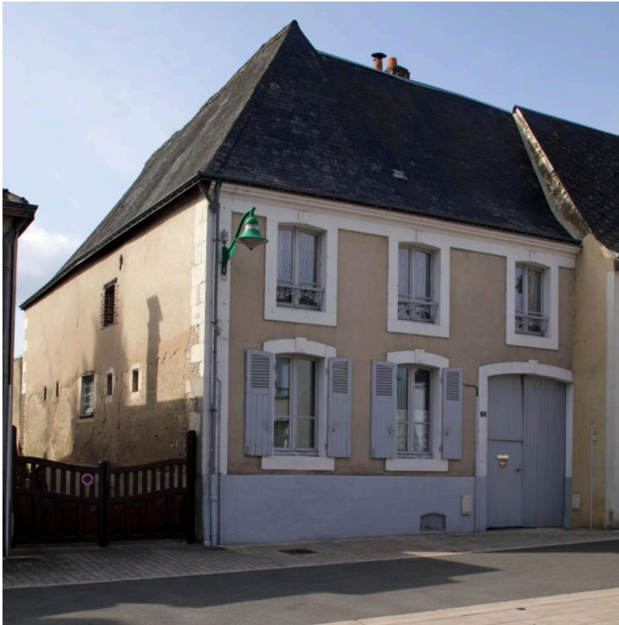
Vue de volume de la maison.
