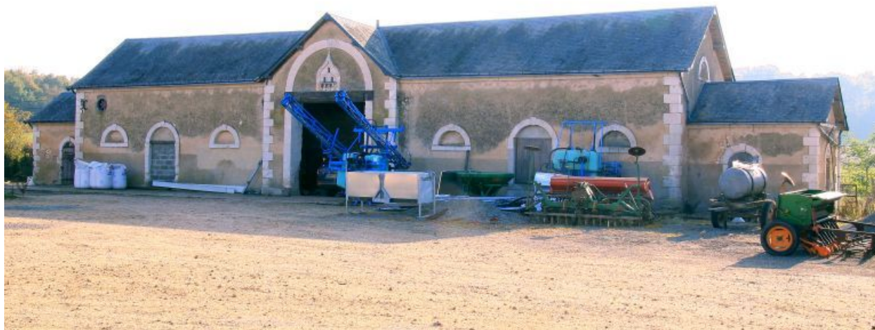
Les étables sud-est : façade sur cour.
