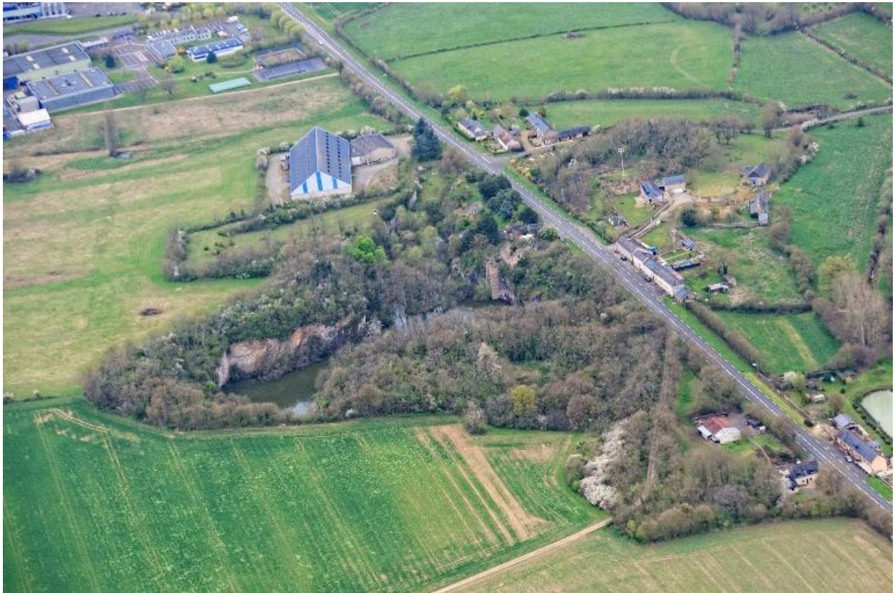
vue aérienne de la carrière de marbre de la Pélivrière, Bouëre, Mayenne.
