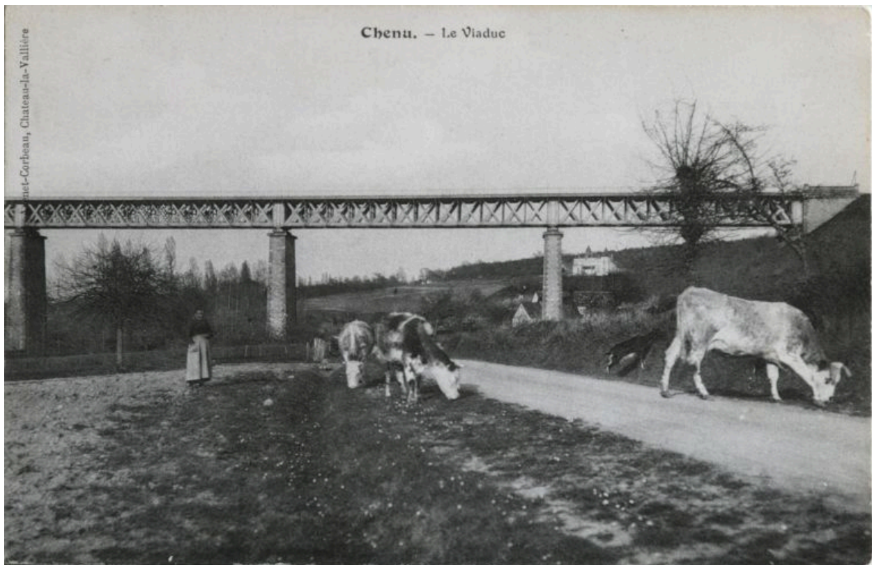
Le viaduc de Chenu pris de l'ouest.
