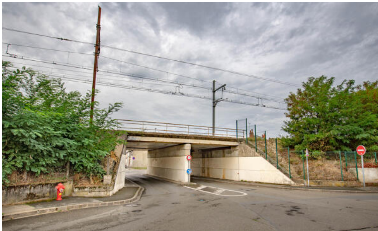
Vue des voies ferrées et du pont menant rue du Préau.
