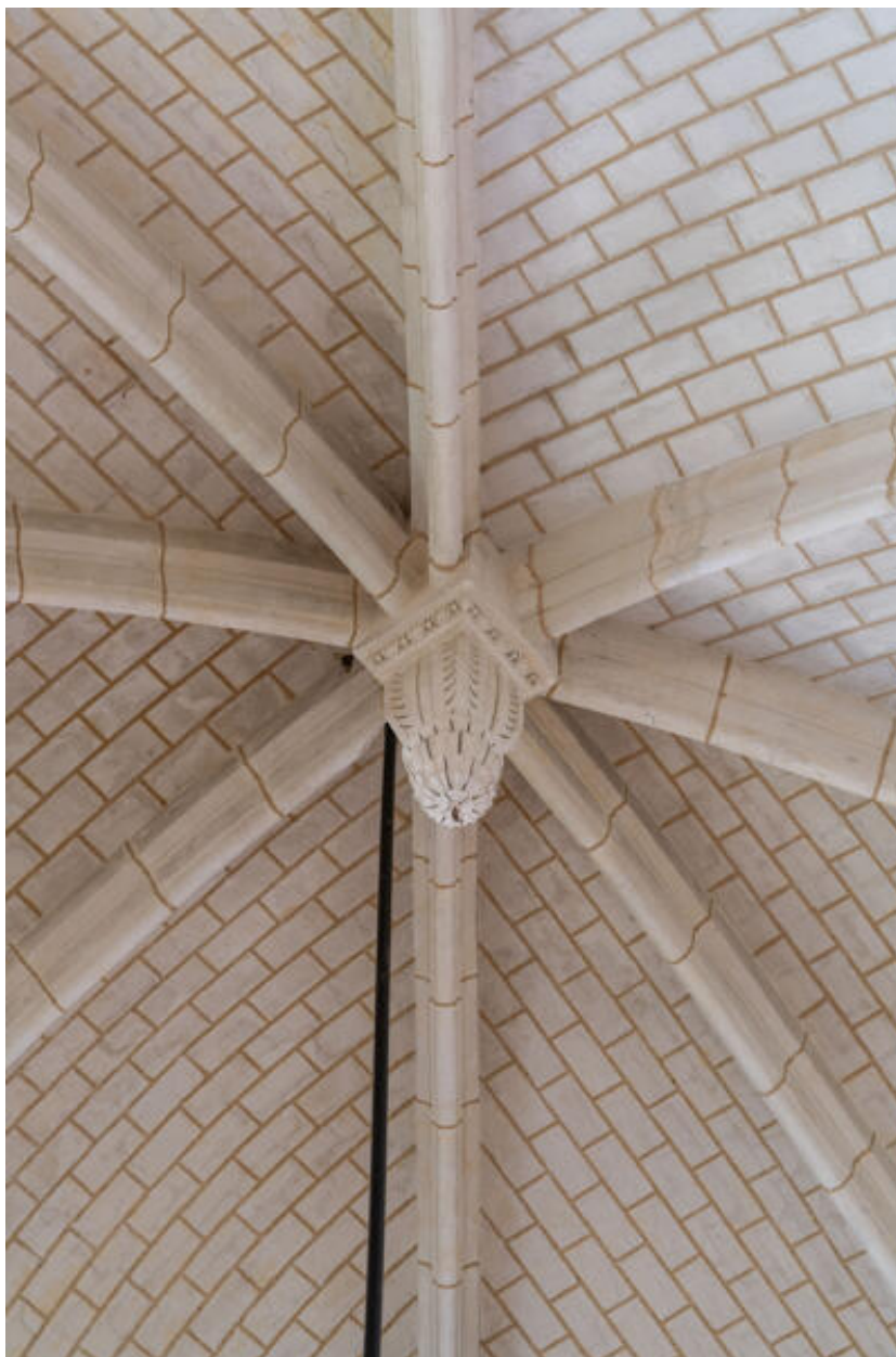
Voûte de la croisée du transept.
