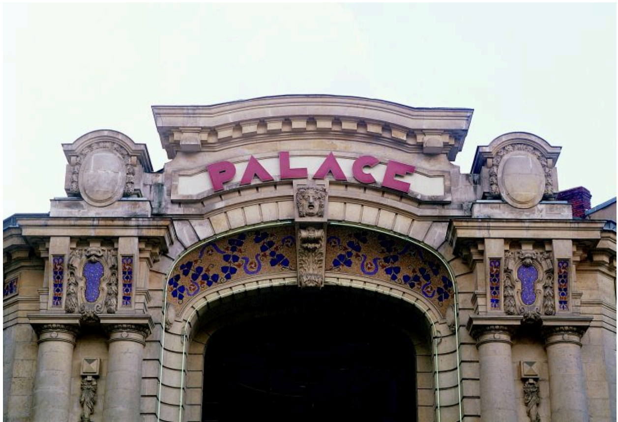
Portail : vue d'ensemble de la partie supérieure.
