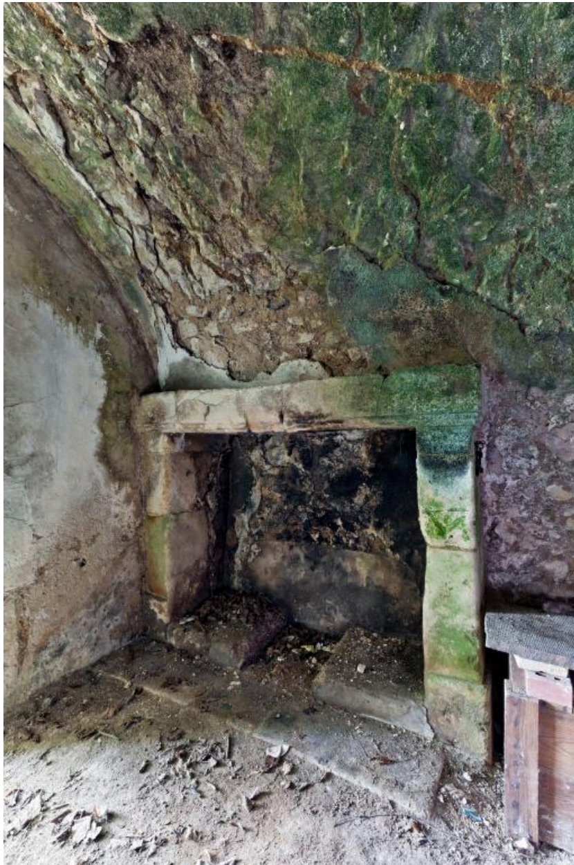
Cave aménagée dans le coteau : cheminée à l'entrée.
