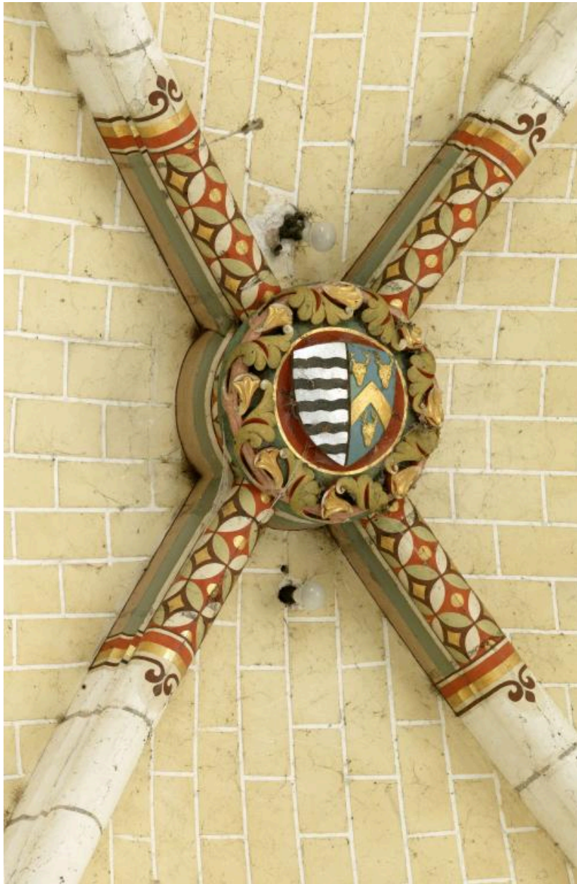
Transept, bras sud : clé de voûte armoriée.
