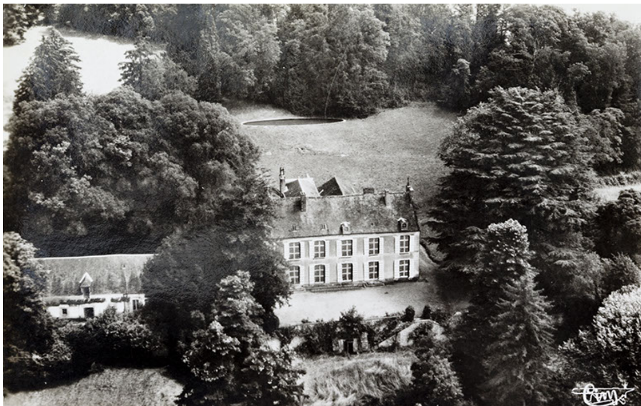
Vue générale du château et des communs.
