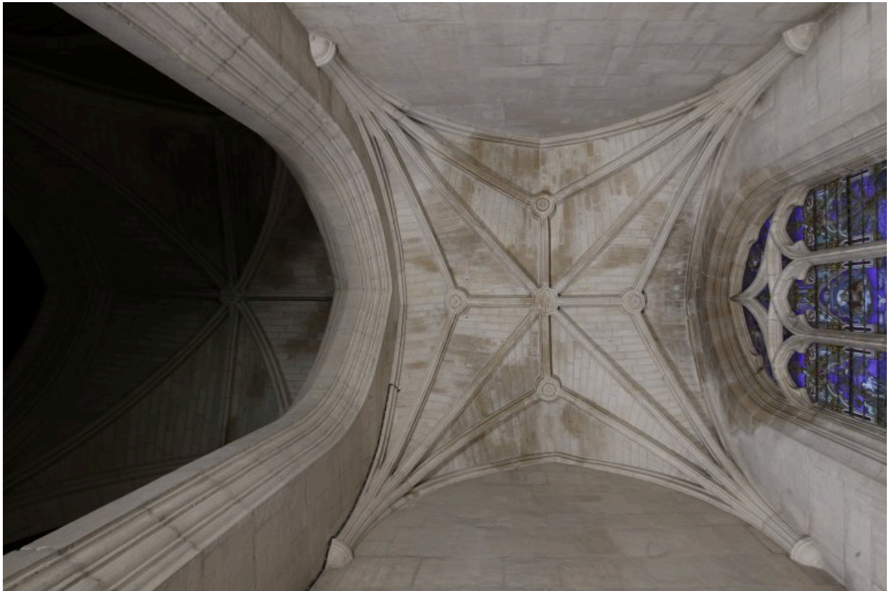
Première chapelle du bas-côté nord de la nef : vue de la voûte.
