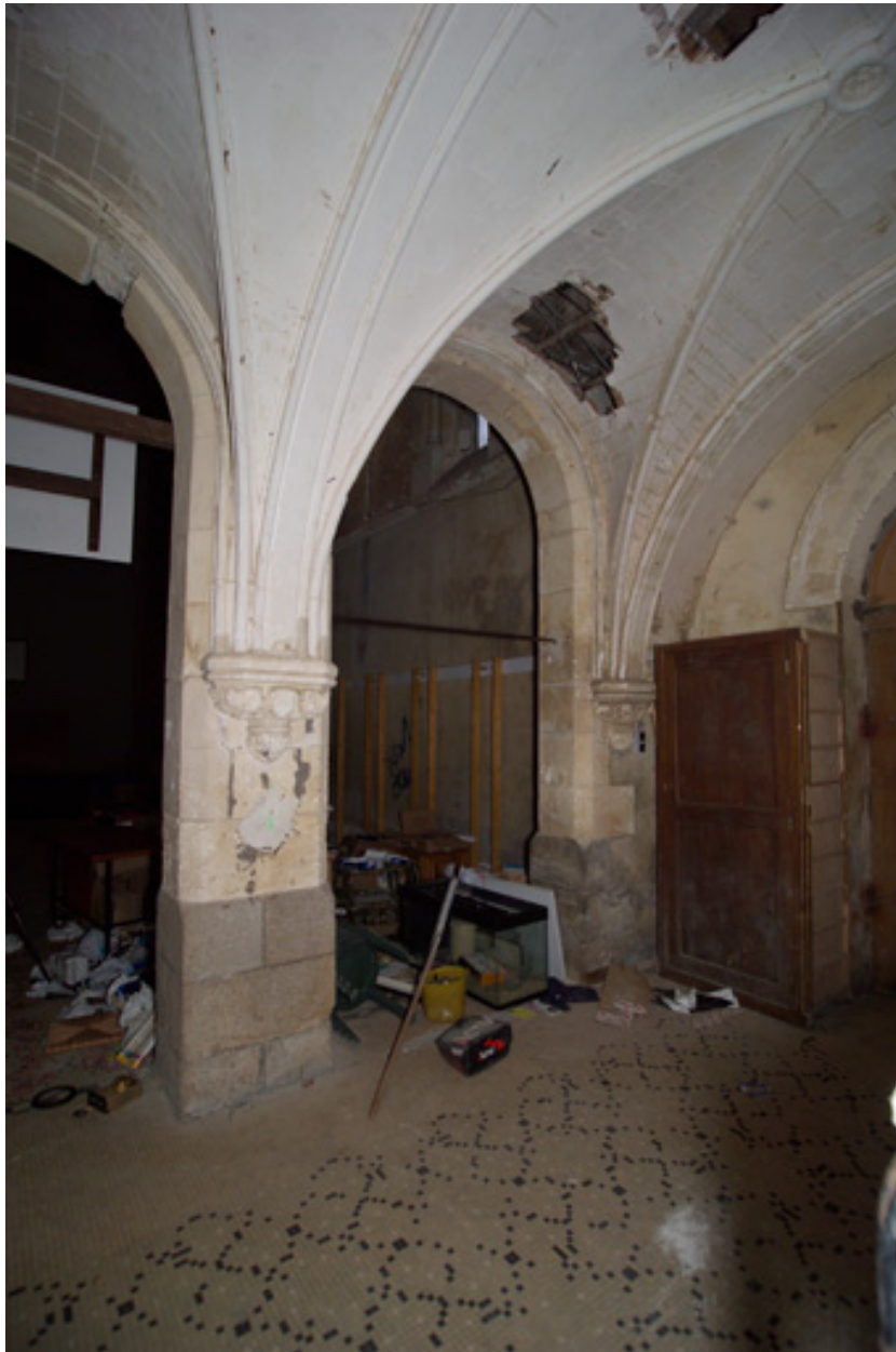
Chapelle, piliers nord du narthex vers la nef.
