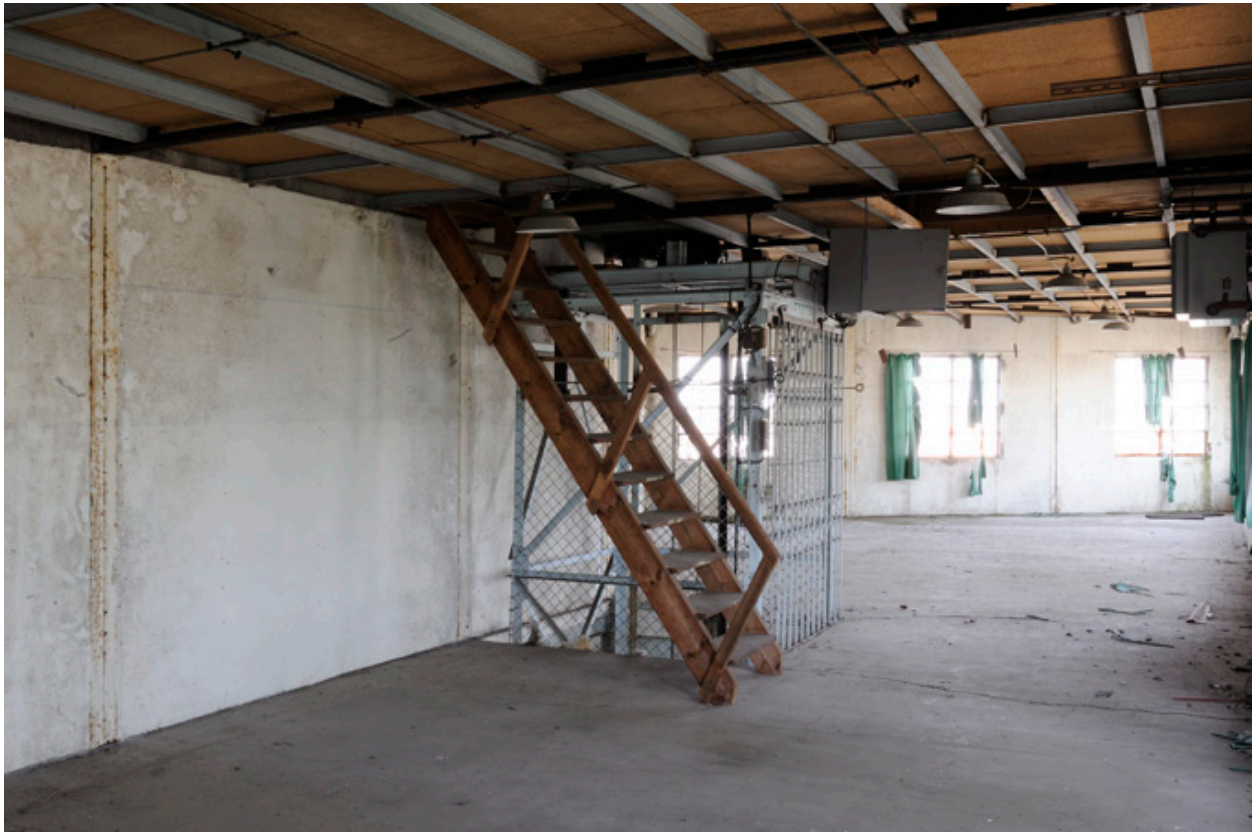
Vue intérieure (2e étage) du bâtiment construit en 1948.
