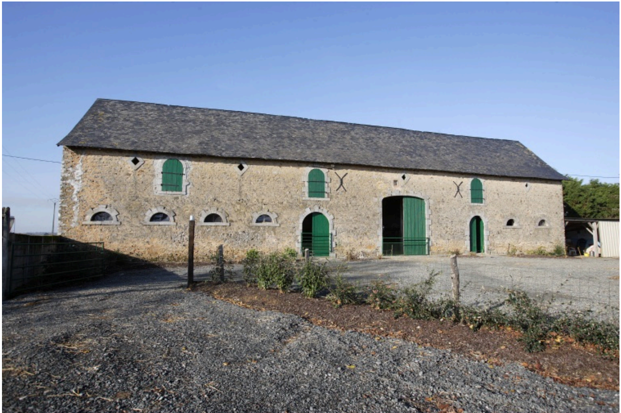
Le logis-étable vu depuis la cour principale au sud-est.
