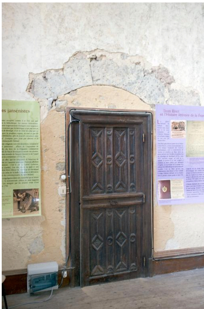
Le pavillon, ancienne porte au rez-de-chaussée, 2007.
