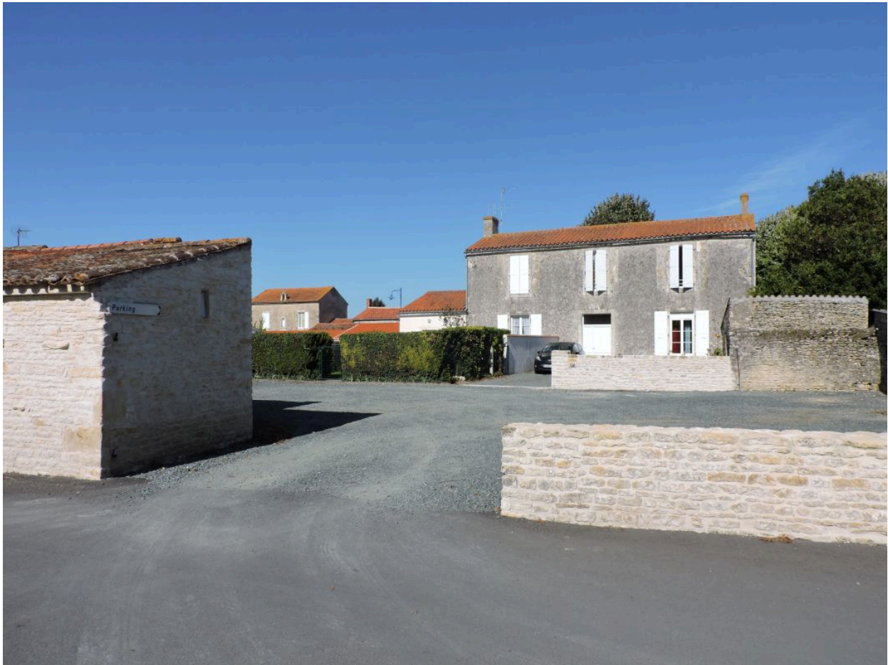
L'ancien presbytère vu depuis le sud.
