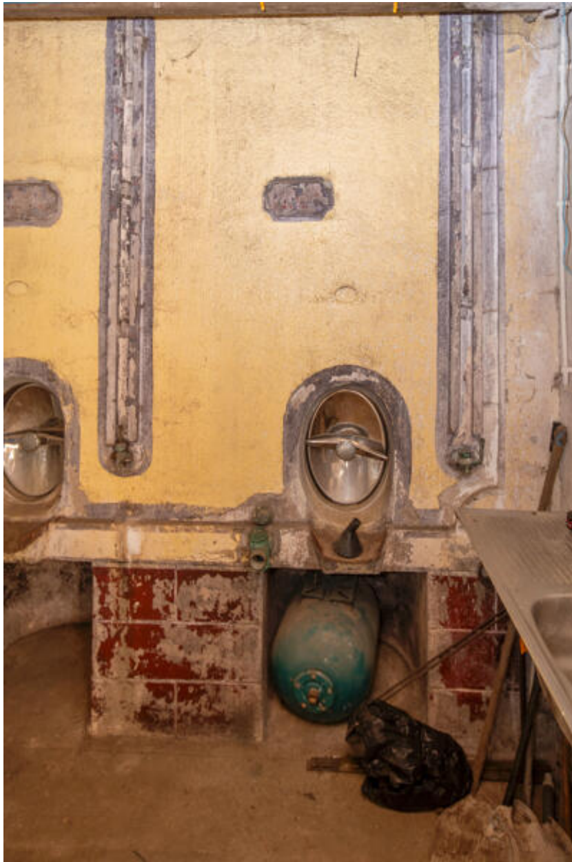
Détail d'une cuve et son soubassement.
