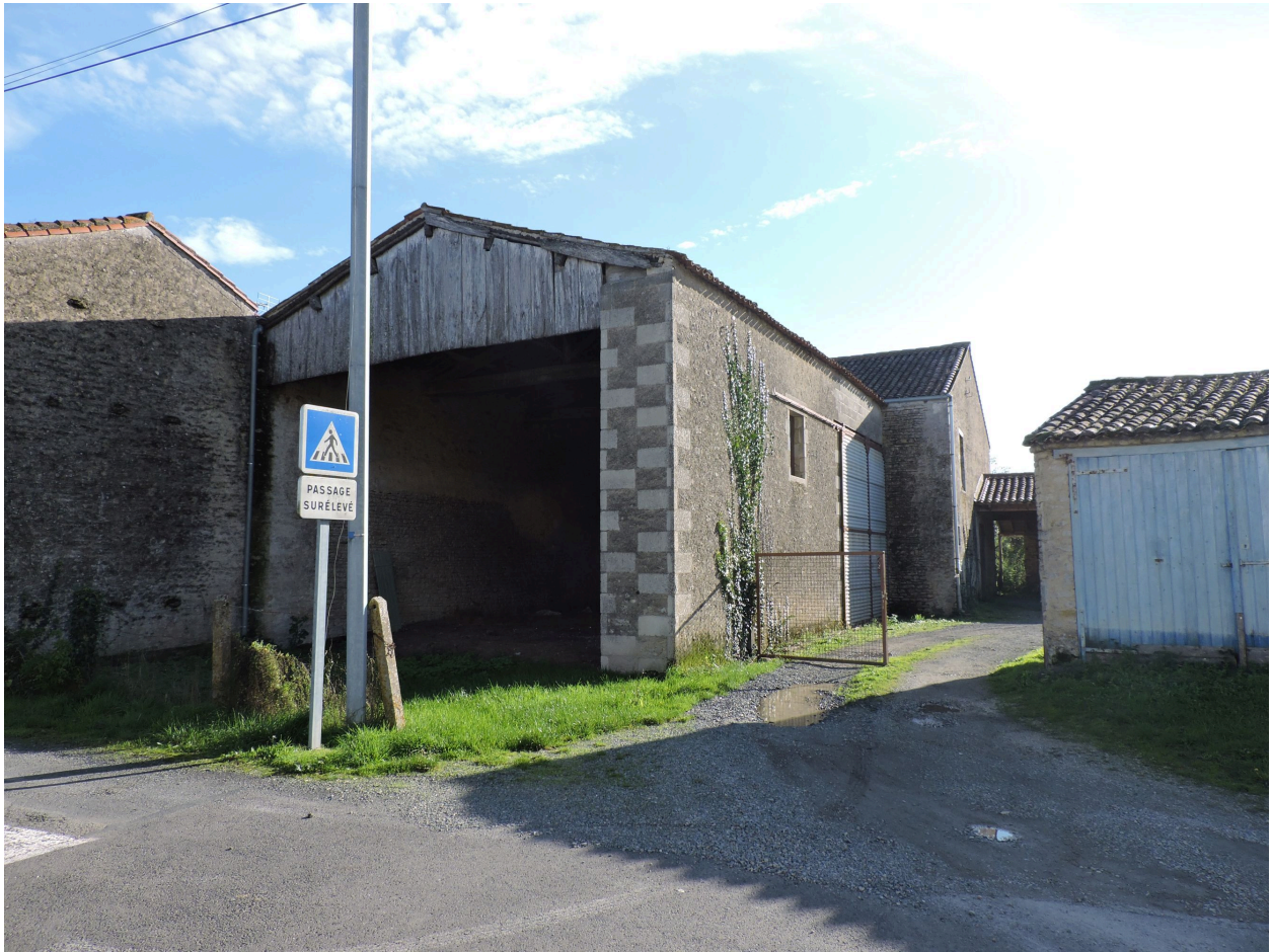
Le hangar à l'est du logis, vu depuis le nord-ouest.
